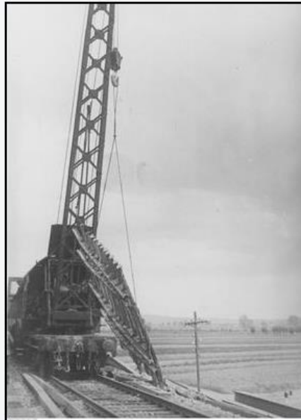
Opis obrazu: Budowa linii kolejowej Sierpc-Toruń - pociąg-dźwig układa szyny kolejowe na torze.
