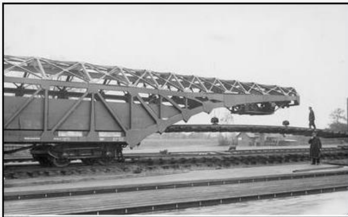
Opis obrazu: Budowa linii kolejowej Sierpc-Toruń - pociąg-dźwig układa szyny kolejowe na torze.
