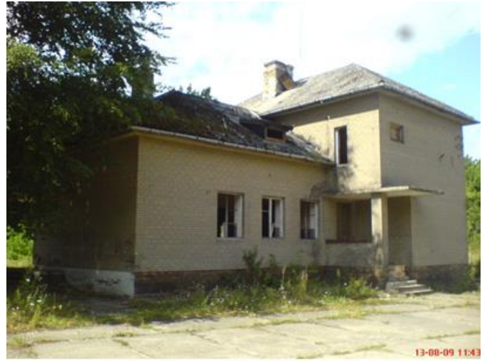
Stacja Szczutowo, widok od strony Szczutowa, 13.08.2009 r
